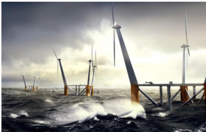
STØRST: Windsea er en plattform med tre vindturbiner som monteres i en trekant. Samlet effekt per enhet er hele 10 MW. Foto: Windsea
